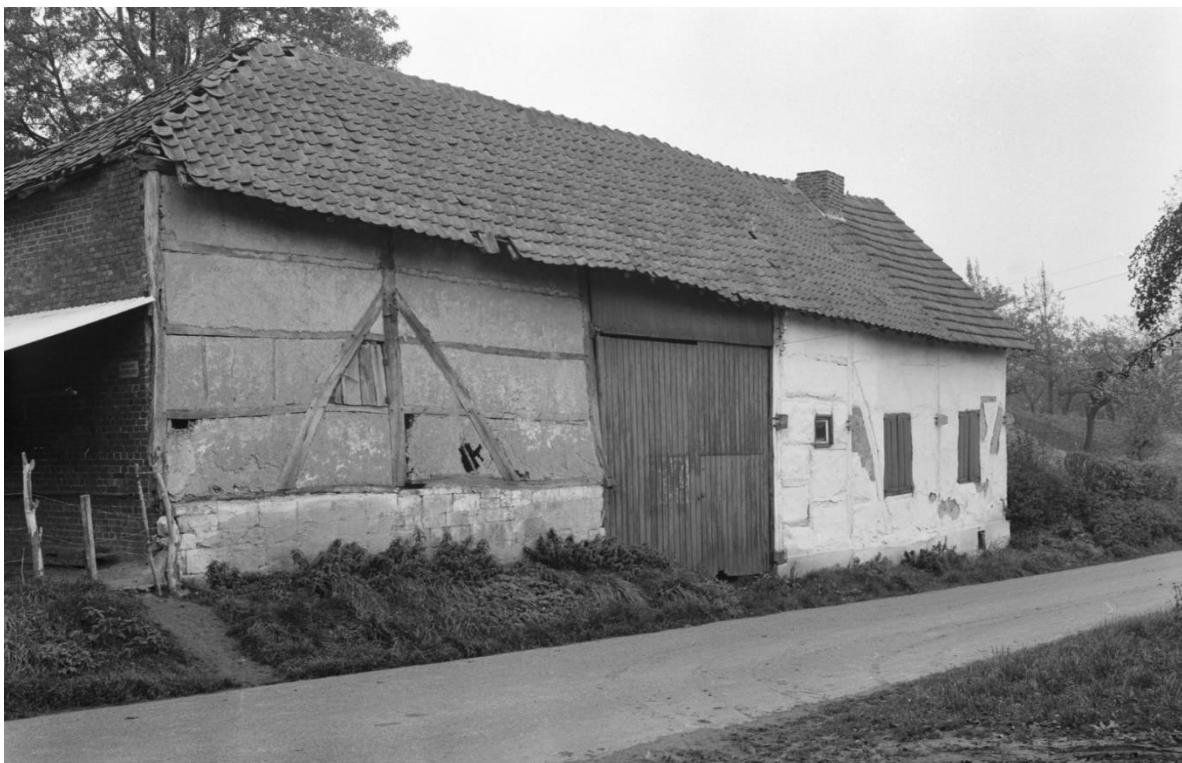
Afb. 2 Deze boerderij van leem en vakwerk (nummer N 76 * van het kaartje) lag aan de noordzijde van de weg naar Schimmert. Ze werd als laatste bewoond door de familie Krutzer-Mulkens. Het woongedeelte lag rechts (wit). Op die plek is nu nog steeds een keldergewelf van mergelstenen zichtbaar in de berm naast de weg, zie ook bijlage 3. Archiefphoto: RCE, 1962.
